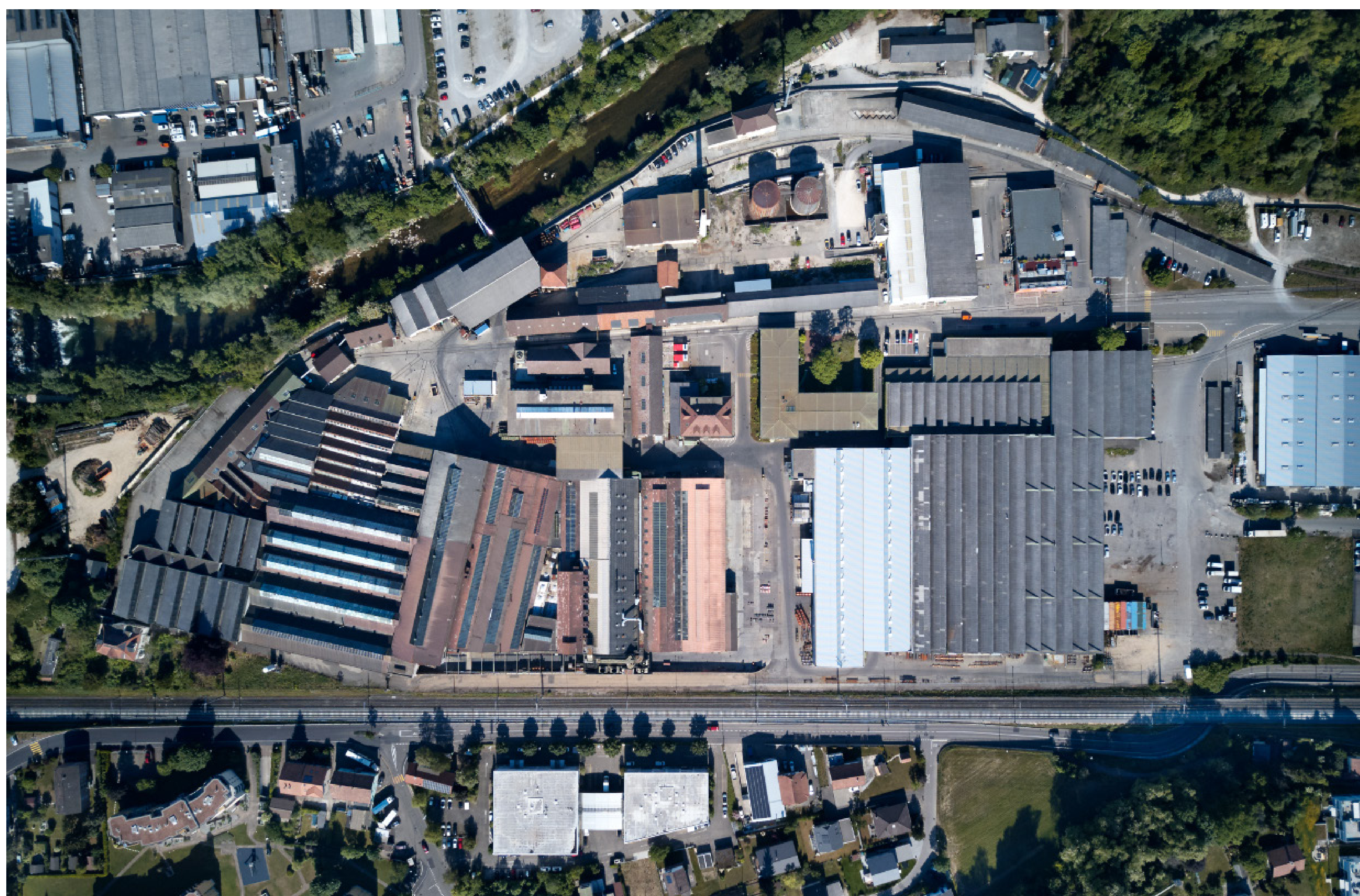
Luftbild 2016: Das Areal ist heute mit Industriegebäuden belegt und weitgehend versiegelt
