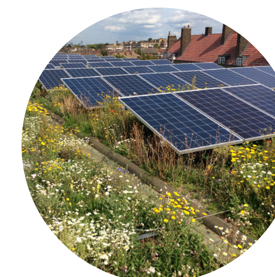
Beispiel Energiegründach: Begrünung und Energieproduktion
